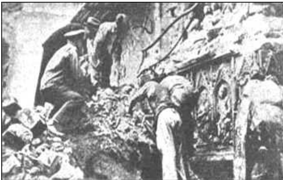
L'altare della chiesa di Santa Chiara distrutto dai bombardamenti
