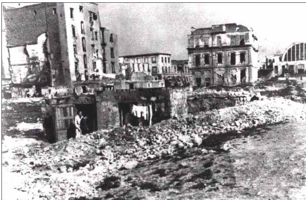
Via Marina totalmente distrutta dai bombardamenti "alleati"
